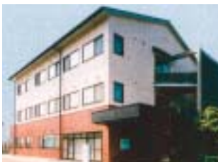
「有沢橋病院」前景
